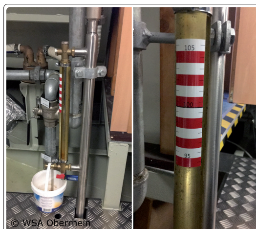
Abb. 2: Schauglas mit einem Steigrohr und einer Skala (links) und die vergrößerte Darstellung der Skala (rechts)
